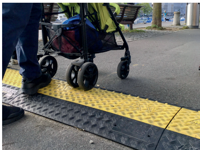
Kabelbrücke in Zürich
